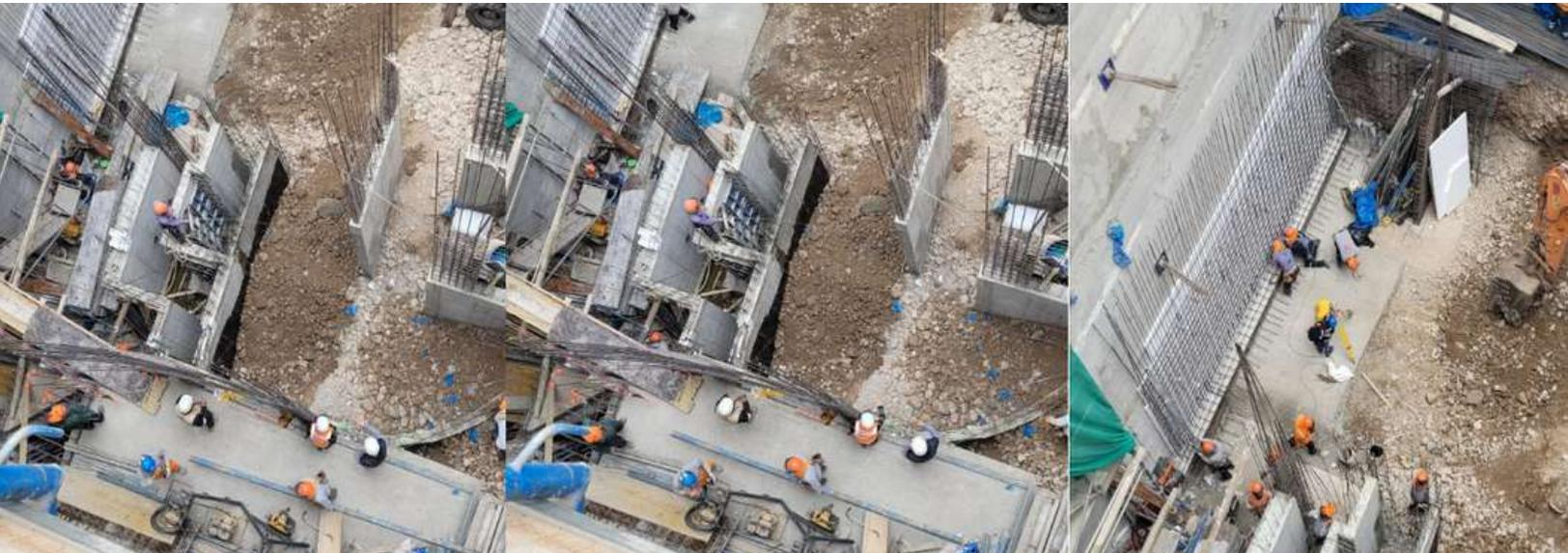
**Desencofrado de muros y colocación de acero en cisterna de agua contra incendios**
