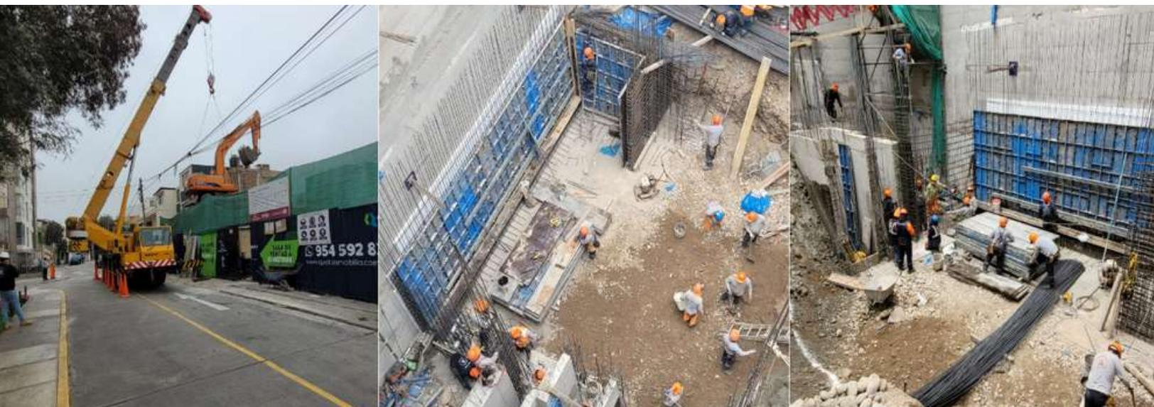
**Retiro de excavadore y trabajos de encofrado en cisterna de agua contra incendios**
