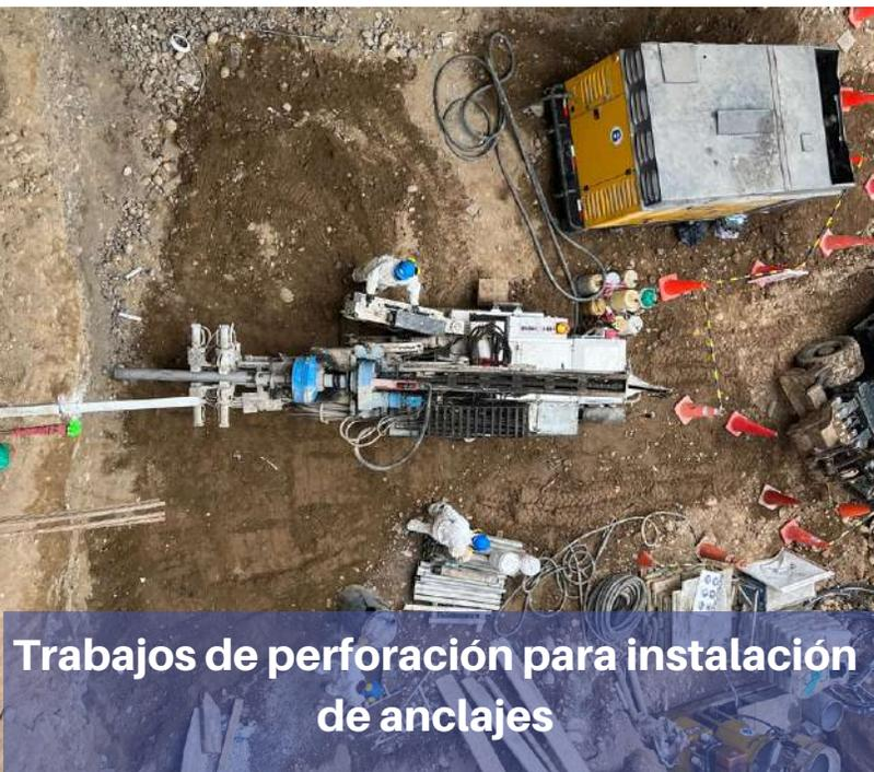
**Trabajos de perforación para instalación de anclajes**
