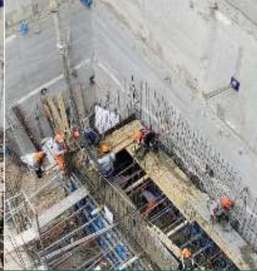
**Solado y colocación de concreto en cisterna de consumo doméstico**
