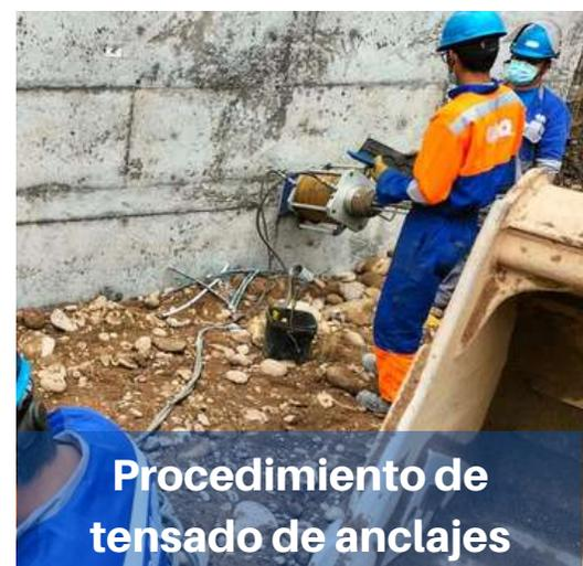
Procedimiento de tensado de anclajes
