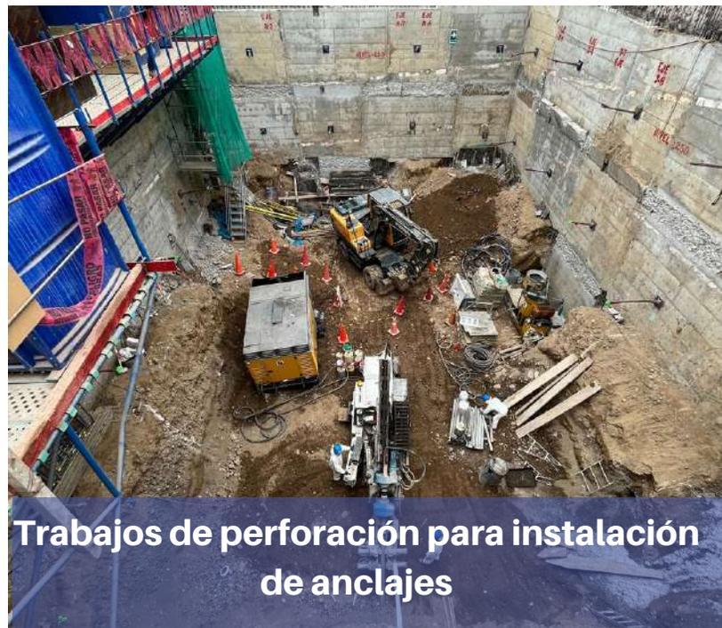
**Trabajos de perforación para instalación de anclajes**
