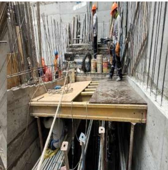
**Desencofrado de placas y encofrado de cimentación y techo de cisterna de consumo doméstico**
