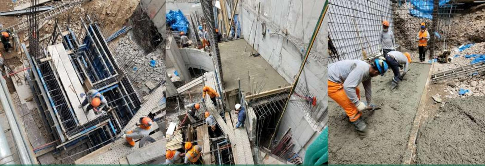
**Colocación de concreto en muros y techo de cisterna de consumo doméstico y solado para cisterna de agua contra incendios**
