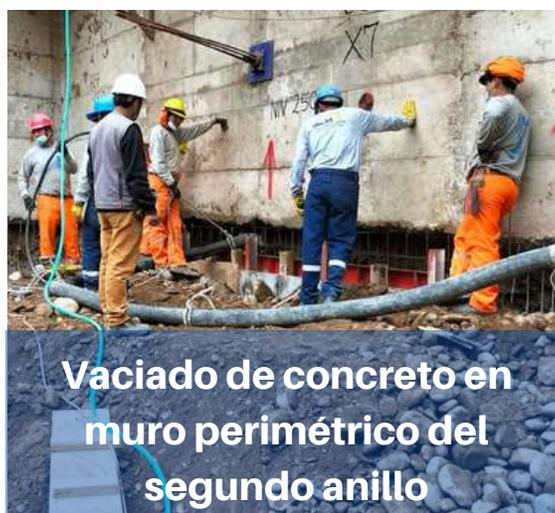
Vaciado de concreto en muro perimétrico del segundo anillo
