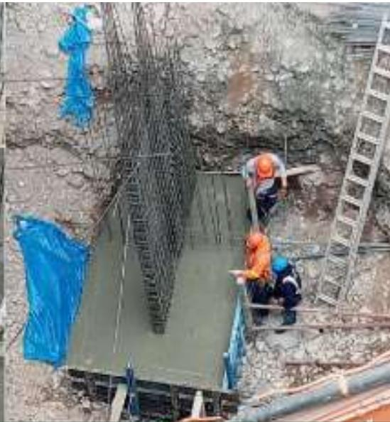
**Desencofrado de placas y curado de cisterna de consumo doméstico y concreto en zapatas de placas**
